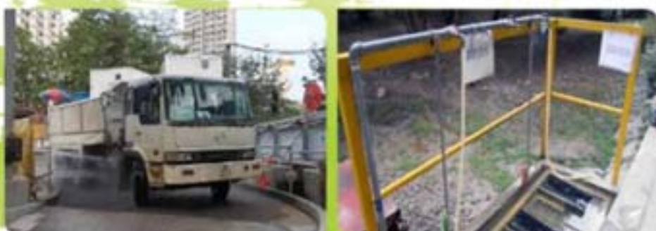
工地出口的輪胎沖洗設施 3
