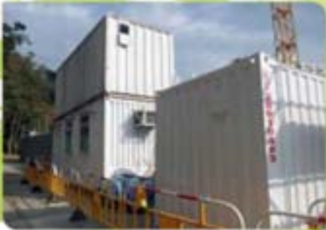
白色的工地寫字樓可減少冷氣耗電量 3
