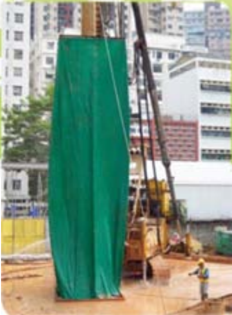
打樁機隔音罩 6
