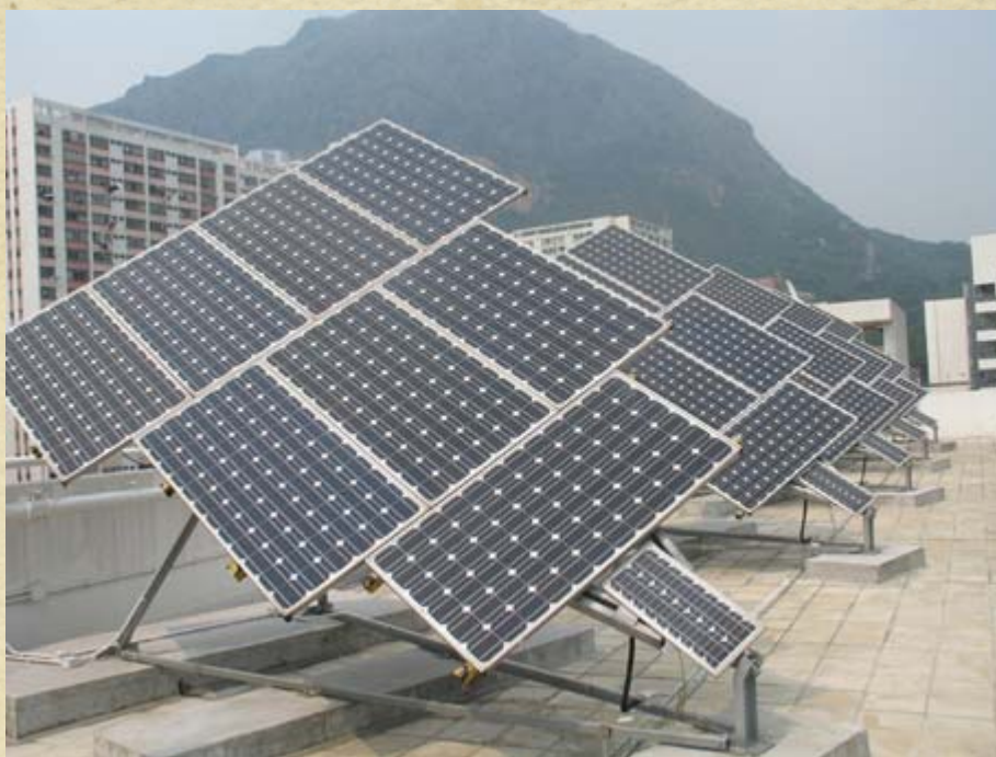
裝有太陽追蹤器的太陽能光伏板
