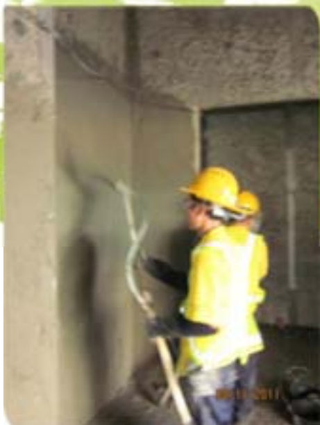
採用預拌批盪灰漿或噴漿批盪，減少在現場攪拌泥沙 4
