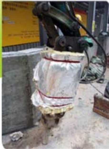
破碎機隔聲套 3
