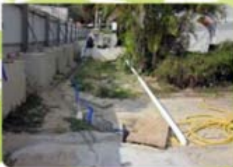
利用U型排水明渠收集雨水 4
