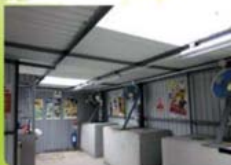
安裝透明天窗利用天然採光節約照明能源 4
