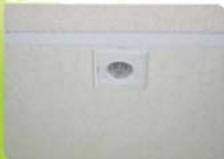
控制寫字樓電燈的移動感應器 4
