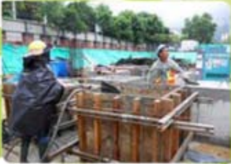
利用剩餘混凝土製作建築組件 5
