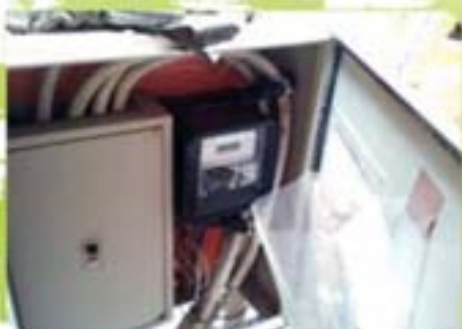
裝設電錶監察工地耗電量 6
