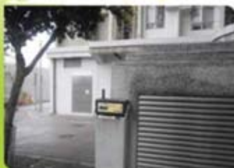
在工地附近設置塵埃監測裝置 5
