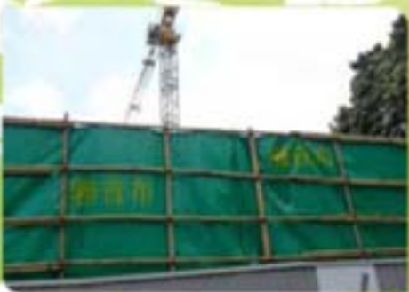
建築工地四周設置隔音屏 2
