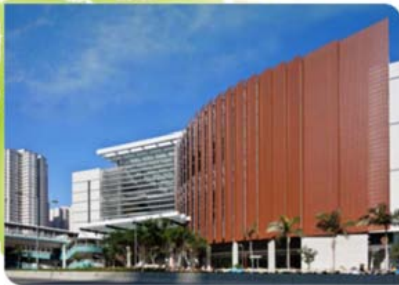
小西灣綜合大樓外貌
