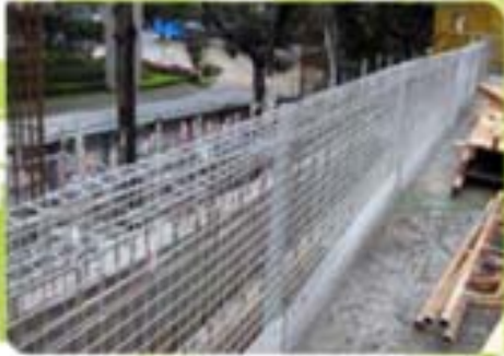
重複使用以往工程項目的金屬圍欄 4
