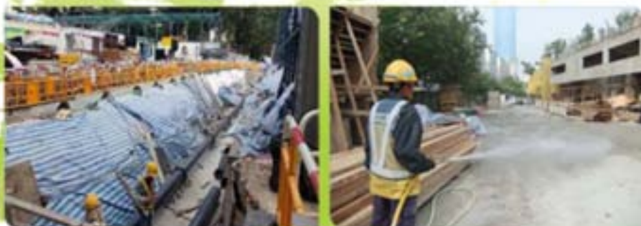
鋪蓋正進行挖土工程的表面 3
